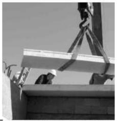
Fig. 5: Montaje de Panel con estingas o bandas.
