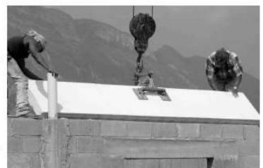
Fig. 7: Montaje de panel Hebel, mediante teneza tijera en lasas de vivienda de interés social.
