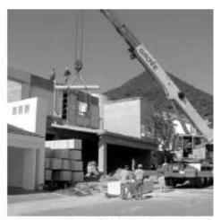
Fig. 6 Instalación de Panel de Azotea con handa.
