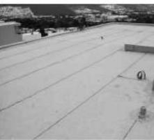
Fig. 20: Imperimesbil vación lipo membrana SBS
