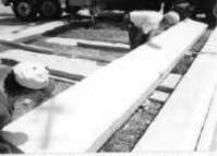
Fig. 10: Girar los paneles 90\* y marcar el centro.
