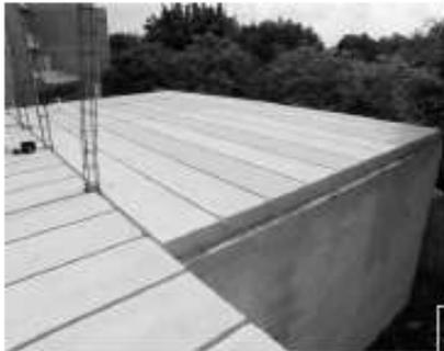
Fig. 18: Panel Hebel para Losa de entrapiso
