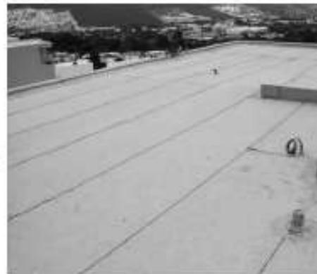
Fig. 20: Impermeabilización tipo membrana SBS
