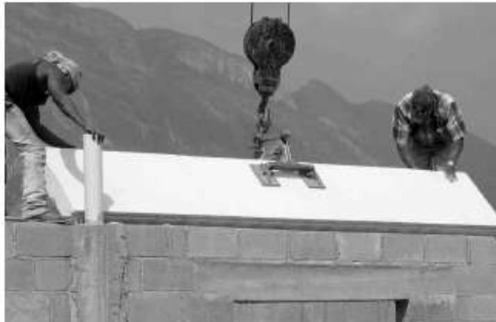
Fig. 7: Montaje de panel Hebel mediante tenaza lijera en losas de vivienda de interés social.
