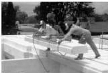
Fig. 11: Soltar las cadenas de seguridad de la tenaza antes de llegar a su posición final.
