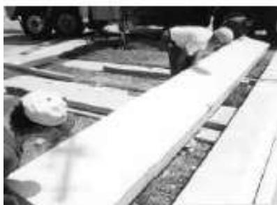
Fig. 10: Girar los paneles 90° y marcar el centro.
